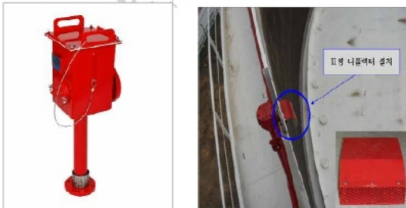
[폼 챔버 예시 및 특형 반사판 부적합 예시]
