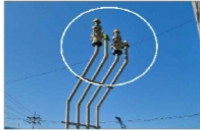
[화염방지장치 및 대기밸브 부착 통기관]
