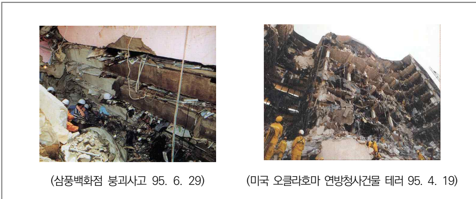
[그림 5-90] 전형적인 팬케이크형 붕괴 [그림 5-91] 캔틸레버형 붕괴
