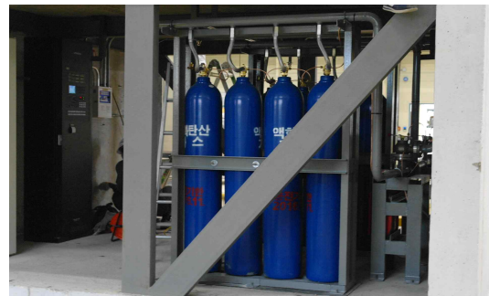
집합형 가스 실린더실 지진발생시 전도방지 설치 예시
